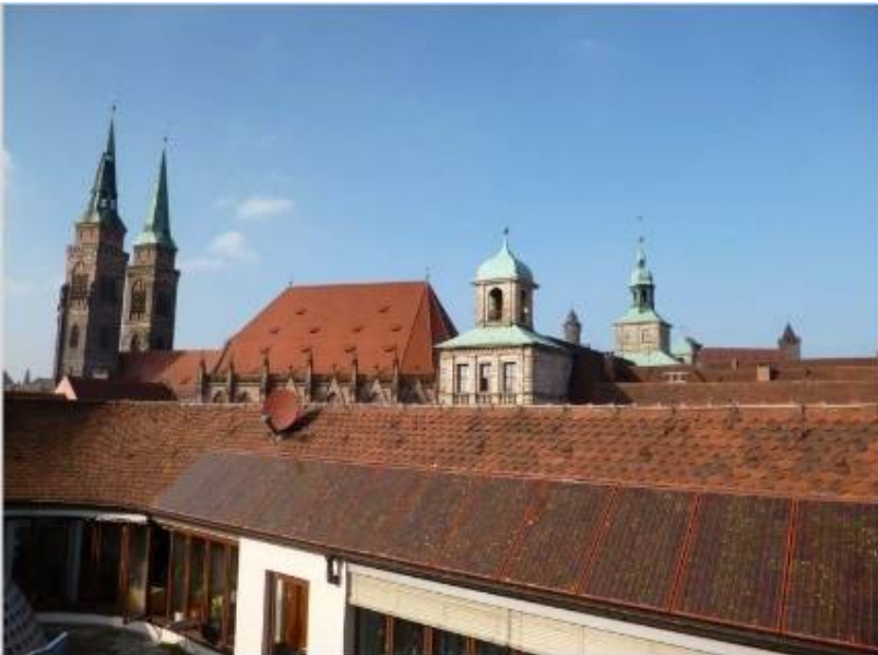
Bild 1: PV-Anlage auf dem Neuen Rathaus, Hauptmarkt 18
