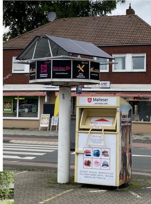
eines #Solartisch! Da eine Außenanbringung wegen der Dachkonstruktion nicht ohne weiteres möglich ist wurde ein Solartisch.de gebaut. Paneel hat 410Wp. Um die Effizienz zu erhöhen, kann das Solarpanel auf von 47° aufgestellt werden
