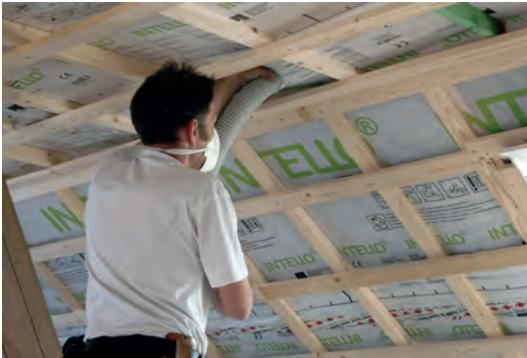
Zellulose wird aus Altpapier gewonnen und einfach in Schichten unter dem Dach oder an der Wand eingeblasen.
