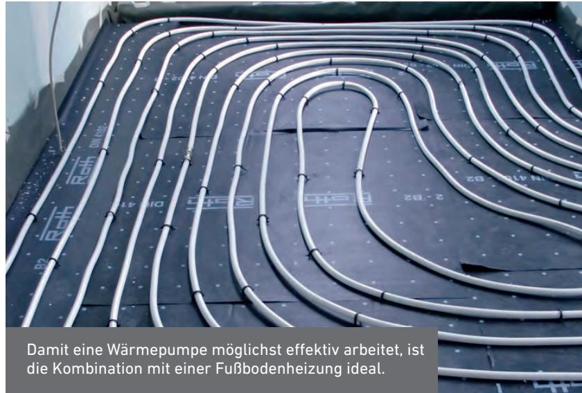
Damit eine Wärmepumpe möglichst effektiv arbeitet, ist die Kombination mit einer Fußbodenheizung ideal.
