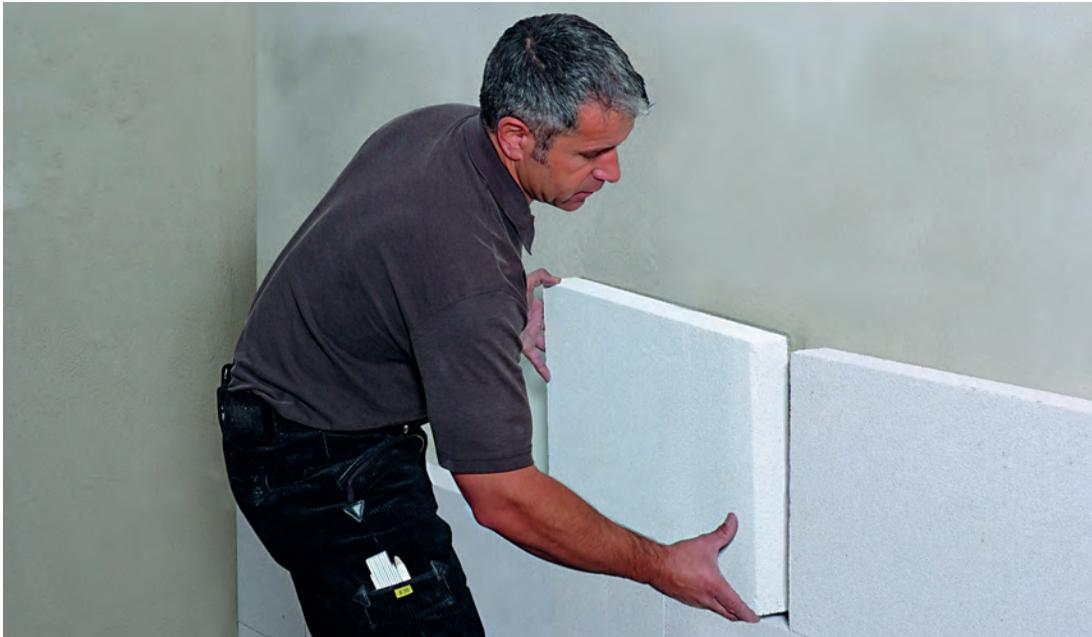
Die Innendämmung muss von einem ausgewiesenen Fachmann gemacht werden. Sonst können Bauschäden entstehen.
